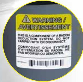
**B. Les étiquettes d'avertissement sur les tuyaux** sont conformes aux directives CAN/ONGC 149.11 et CAN/ONGC 149.12.
