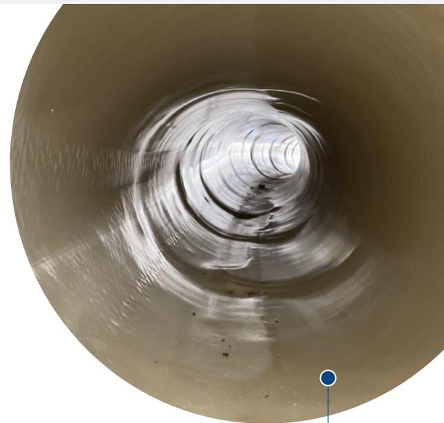
Tuyau entièrement fonctionnel après l'insertion d'une gaine en PVC NovaForm dans le tuyau en terre cuite existant.
