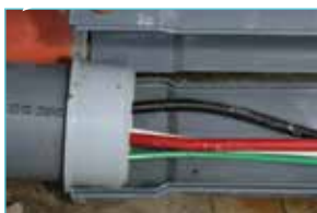
COLLER LA TROUSSE EPR À SA PLACE
