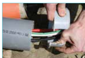
OUVRIR ADAPTATEUR AUTOUR DU CÂBLE
