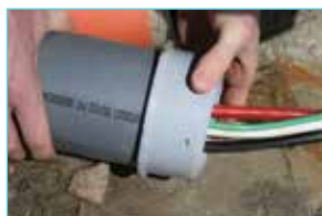
COLLER L'ADAPTATEUR AU CONDUIT
