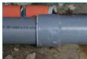
RÉSULTAT : CONDUIT TOTALEMENT RESTAURÉ
