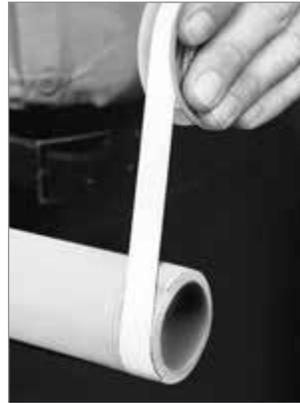
Enrouler le ruban sur toute la longueur des filets, en commençant par le deuxième à partir de l'extrémité. Faire chevaucher le ruban légèrement d'un tour à l'autre, dans le même sens que les filets. On empêche ainsi le ruban de se dérouler lorsqu'on serre un raccord sur le tuyau. En faisant chevaucher le ruban dans le mauvais sens et en en mettant trop, on risque de ne plus respecter les tolérances entre les filets. Il
