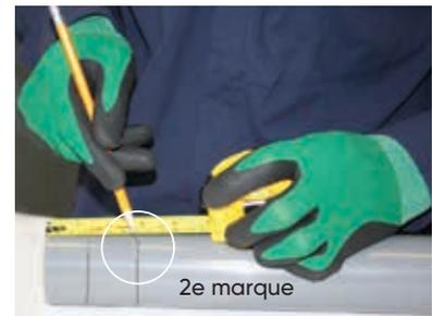
Faire une 2e marque sur le DE du tuyau. La distance entre la seconde marque et la première marque doit être la même que la profondeur d'emboîture du raccord.
