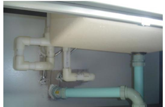
Le système IPEX Enpure<sup>MD</sup> a été utilisé pour le traitement très haute pureté de l'eau et le système de distribution à osmose inversée
