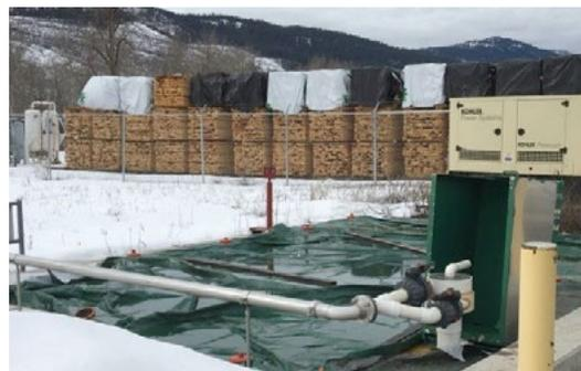
dispositif Force Vortex était en mesure d'augmenter la teneur en oxygène dissous de pratiquement zéro à plus de 5 mg/L en moins d'une heure. Dans ces conditions aérobies, pratiquement tout le H<sub>2</sub>S est détruit et la teneur importante en oxygène dissous empêche qu'il ne se reforme.
