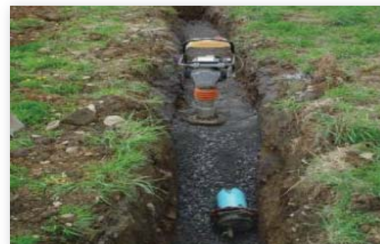
Photo 3 : La tuyauterie sur assise et recouverte a été obturée, remplie et mise sous pression.
