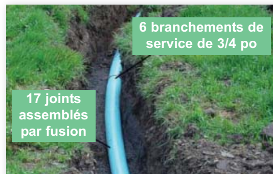
Photo 2 : six branchements de service de 3/4 po et dix-sept joints assemblés par fusion ont été installés.
