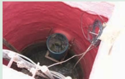
Colonne à vortex Vortex Flow en service dans un puits humide de station de pompage, Jacksonville, Floride.
