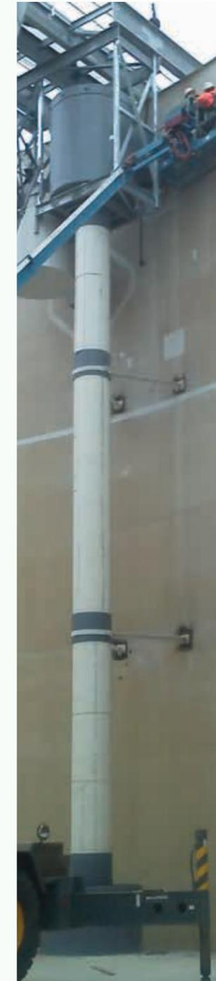
(CI-DESSUS À DROITE) : Colonne à vortex installée dans un réservoir de stockage en cas de débordement d'égouts combinés (CSO) de 5 millions de gallons adjacent à l'usine de traitement des eaux usées - Port Angeles, WA
