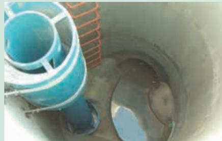
Deuxième conduite d'effluent au bas, prenant appui à partir du puits dissipateur d'énergie (EDP) afin de diriger l'écoulement, Sarnia, Ontario.
