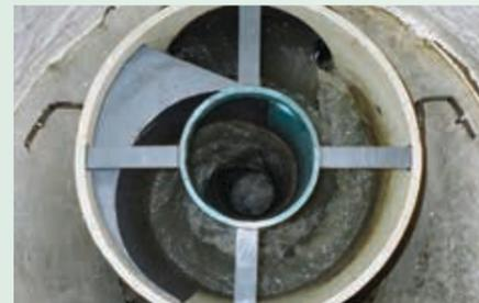
Colonne à vortex Vortex Flow réduisant la concentration en H<sub>2</sub>S, Camden County, New Jersey.
